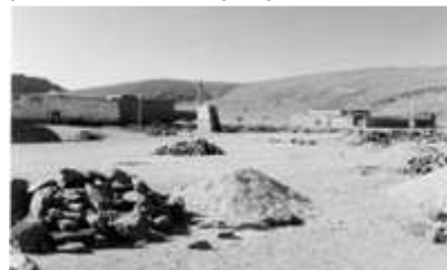
Terrain de construction de la bibliothèque
